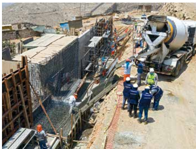
➤ Muros de contención.
