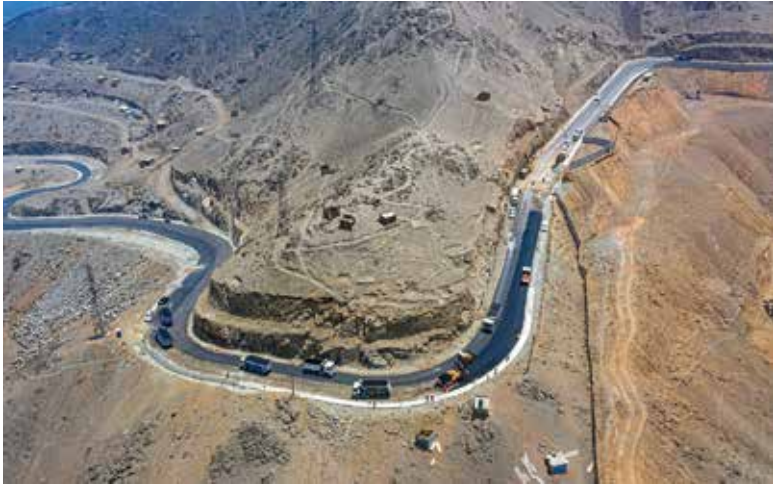
Trabajo de asfaltado.
