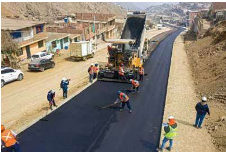
Esparcido de asfalto.
