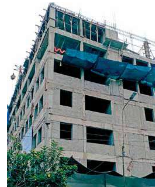
El proyecto Encalada 111 está utilizando el Bloque Modelo Europeo con las medidas 9 cm y 12 cm de ancho.
