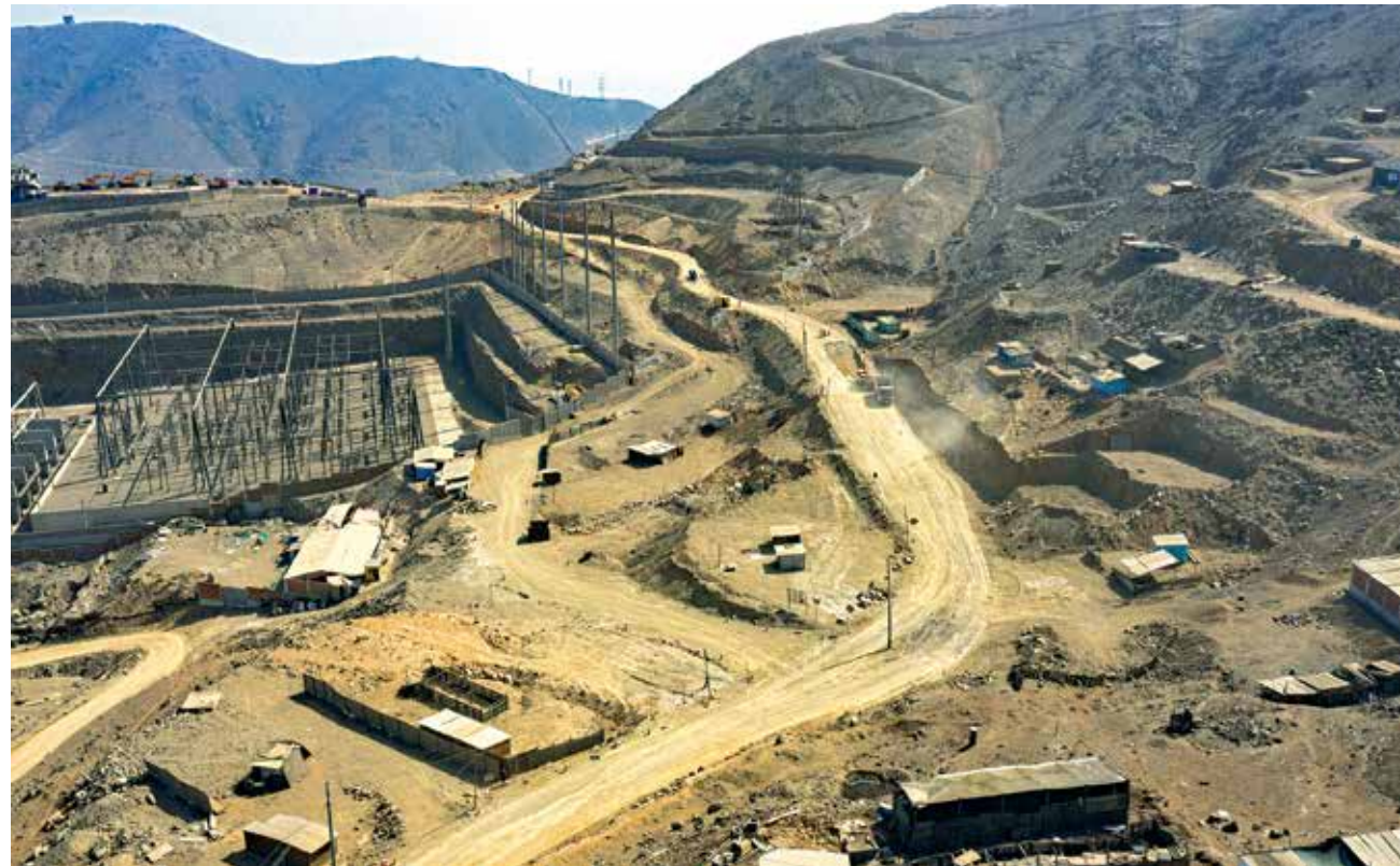
➤ Inicios de la obra Av. Arq. Fernando Belaúnde Terry (Pasamayito).
