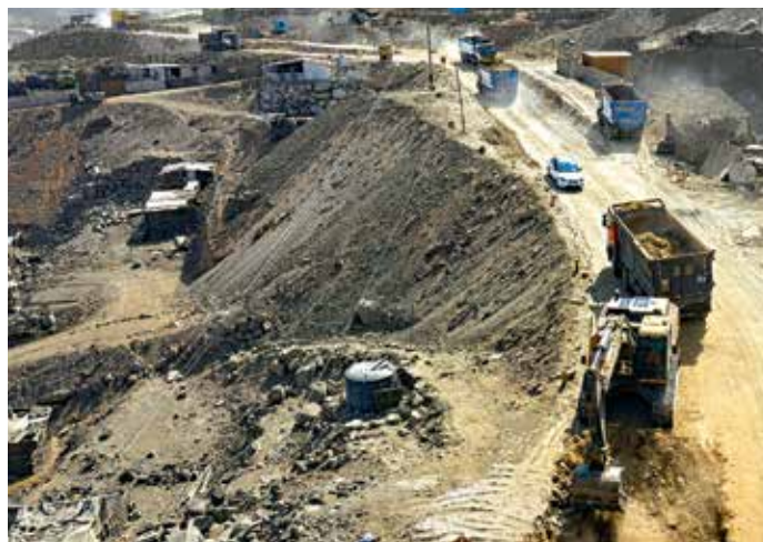
➤ Eliminación de material excedente.
