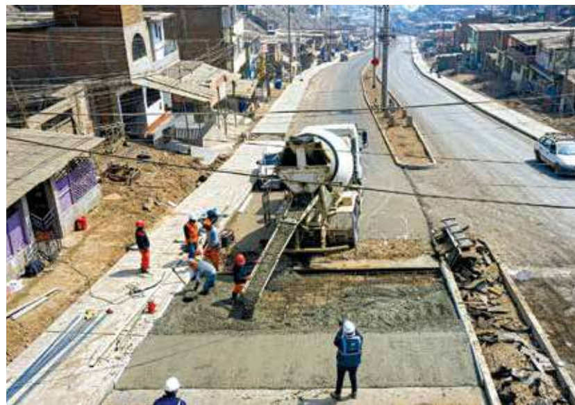
Vaciado con concreto premezclado.
